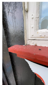
Kledning er ført ned på vannbrett, risiko for fuktopptrekk.
