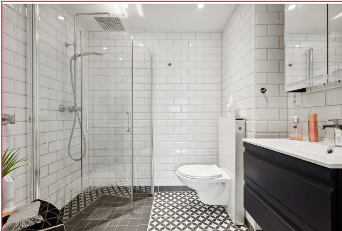
Lekker bad med flotte fliser og varme i gulv - her er det opplegg for vaskemaskin
