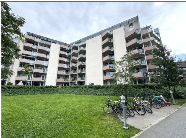
Fasade sett fra felleshage. Leiligheten ligger i 5.etg
