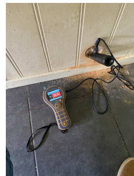
Bildet viser fuktmåling av bad.
