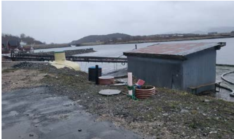
Figur 6: Fotografi av observert septiktank samt nedgravde tanker innenfor tiltaksområdet ved sør-østlig del av området ved bryggen. Bilde ble tatt av NIRAS Norge AS den 07.02.2023.
