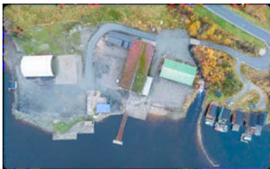
Dronefoto over dagens situasjon
