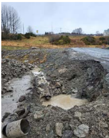
Figur 9: Fotografi av observert nedgravd dreneringsrør innenfor tiltaksområdet som er antatt drenere fra nord til sør-øst mot sjøen. Bilde ble tatt av NIRAS Norge AS den 07.02.2023.
