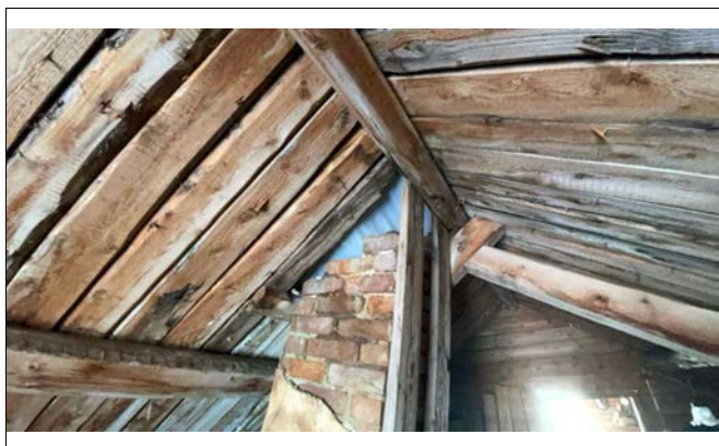
Pipe som er kappet inder taktekkere.
