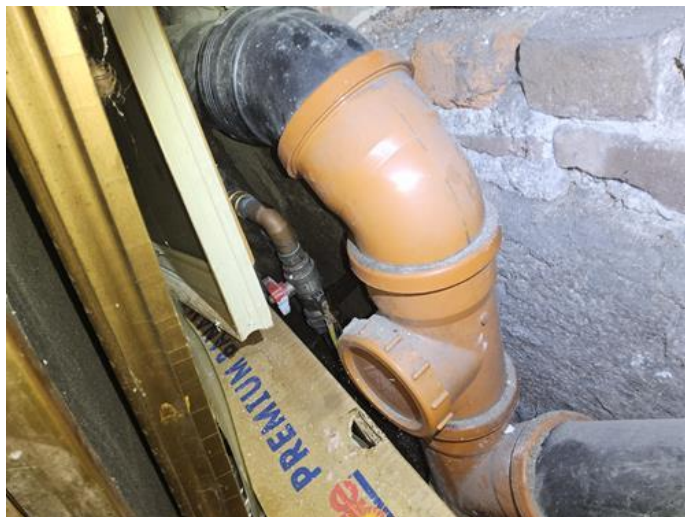
Tekniske anlegg, VVS anlegg (Sjekkpunkter utover det som er inkludert i andre rom) - [Hovedstoppekran og stakeluke]
