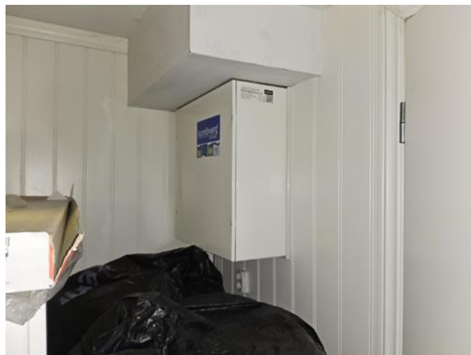
Tekniske anlegg, VVS anlegg (Sjekkpunkter utover det som er inkludert i andre rom) - [Ventilasjonsaggregat leilighet 1. etg øst. ]
