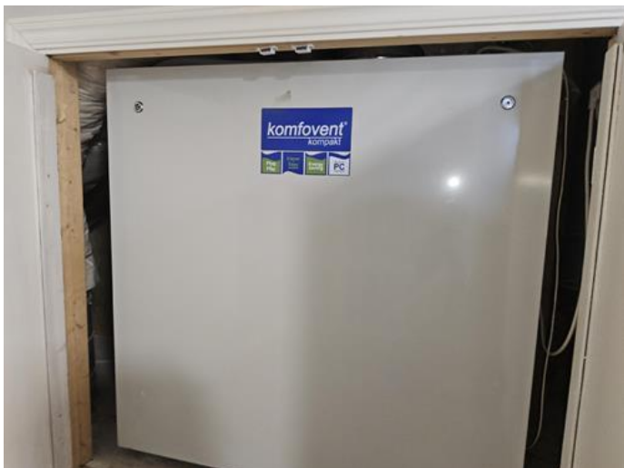
Tekniske anlegg, VVS anlegg (Sjekkpunkter utover det som er inkludert i andre rom) - [Ventilasjonsaggregat på lofts.]
