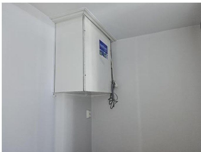
Tekniske anlegg, VVS anlegg (Sjekkpunkter utover det som er inkludert i andre rom) - [Ventilasjonsaggregat leilighet 1.]
