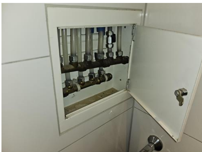
Tekniske anlegg, VVS anlegg (Sjekkpunkter utover det som er inkludert i andre rom) - [Vannskap bad leilighet 1. etg øst]
