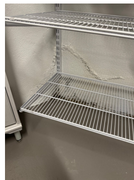
Saltutslag registrert. Saltutslag er en sikker indikator på fuktgjennomgang.
