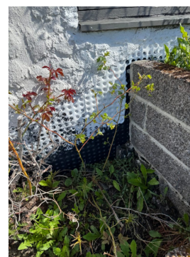
Stedvis synlig grunnmursplast.
