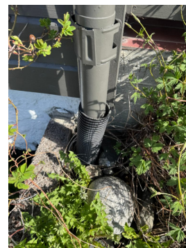
Takrennene er tilkoblet rørsystem for bortledning av vann.
