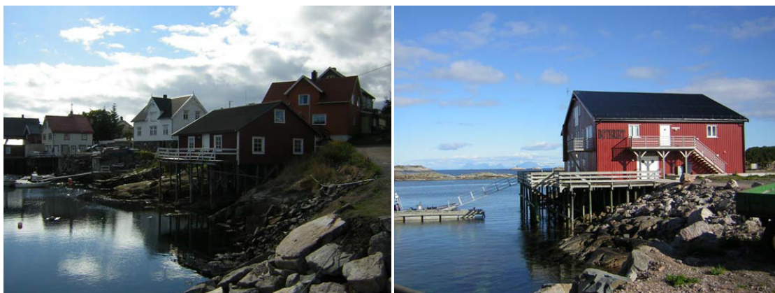
Til venstre: Tradisjonell kant mot Misværholla med blanding av steinbrygger, pelebrygger og naturlig terreng. Til høyre: Skrå plastringer i forgrunnen er avvisende krever også mye plass.
