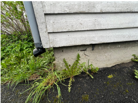
Synlig rust på armering.
