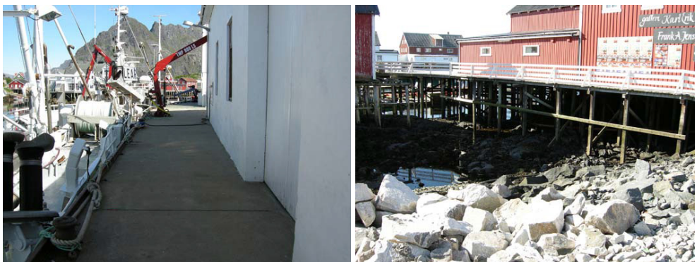
Tradisjonell fiskerikai i betong i kategori 2 til venstre, til høyre vises hvordan pelekaier trekker vannet inn mellom bebyggelsen.
