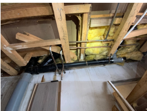
Dårlig festet vannrør
