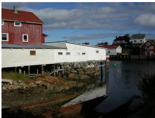
Sløyekur ved Storbuhaugen. De ulike etappene synes i veggene og forteller en historie.
