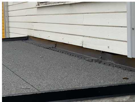
En del ufagmessig skrudd festet ned mot tekke
