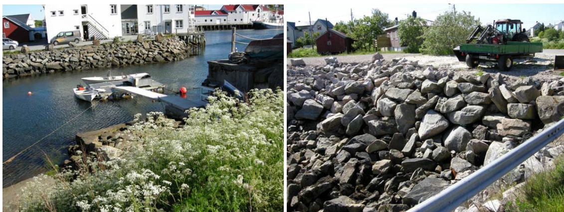
Til venstre: Plastringen fra Bryggehotellet er for skrå og bør mures opp. Kanten mot parkering/vei bør tilpasses situasjonen beder (kaiform). Til høyre: ny kant ved Finnholmen som skaper ny skrå plastring. Utformingen bør bearbeides som kaifront, og enten være slak som en slipp, murt kant eller at det settes på trebrygge.
