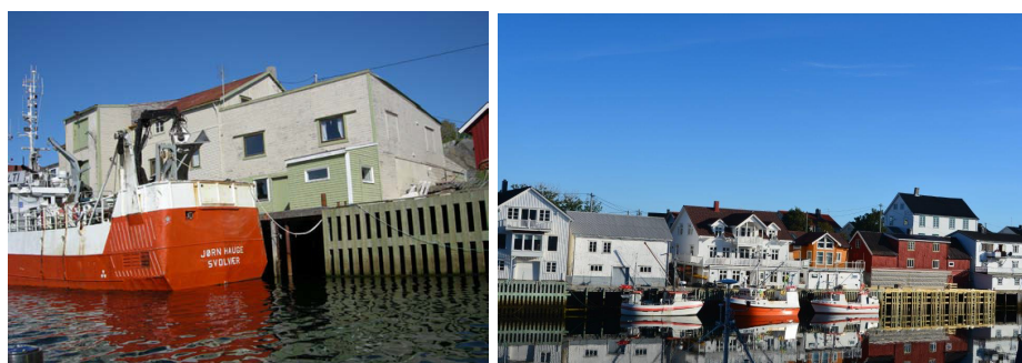
Eksempler på bruk av skjørt som fendere. Bildet t.h. viser skjørt på ny kai gnr 5 bnr 306 (rød brygge) etablert i 2014 (foto: Dagfinn Claudius)
