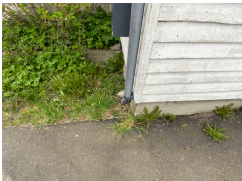
Takvann ledes ut ved mur
