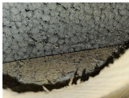
Ikke tegn til misfarging inne i konstruksjonen.
