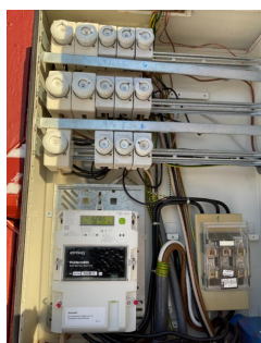
Mangler deksel på koblingsboks.
