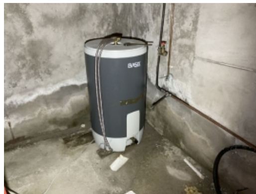
Nyere bereder, ikke tilkoblet.
