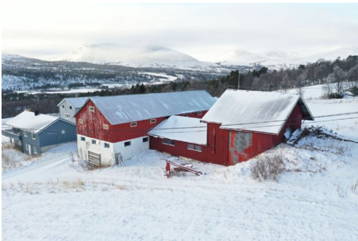
Driftsbygning med siloer
