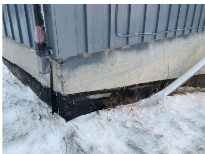
Taknedløp ført ned ved grunnmuren.
