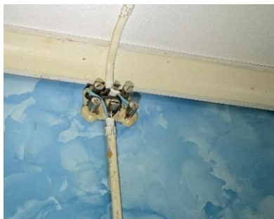
Mangler deksel på koblingsboks.
