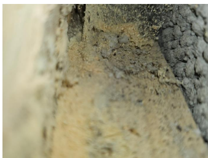
Det er ikke påvist misfarging eller andre symptomer inne i veggen.
