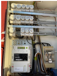
Mangler deksel på koblingsboks.
