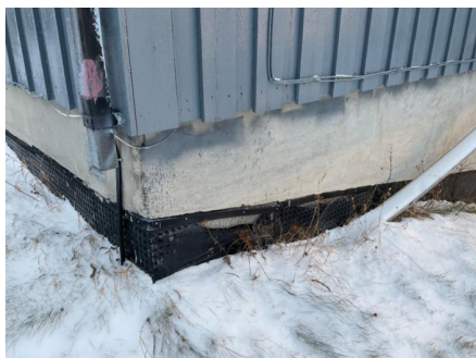
Taknedløp ført ned ved grunnmuren.
