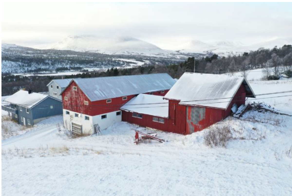
Driftsbygning med siloer
