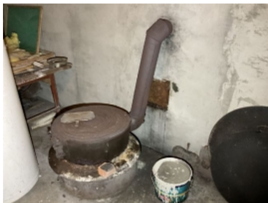
Sotluke bak takke i kjelleren.
