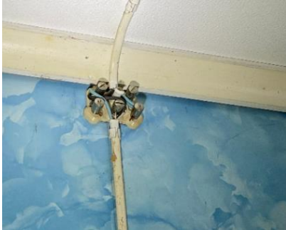
Mangler deksel på koblingsboks.
