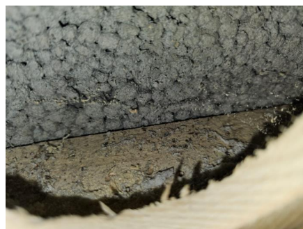
Ikke tegn til misfarging inne i konstruksjonen.
