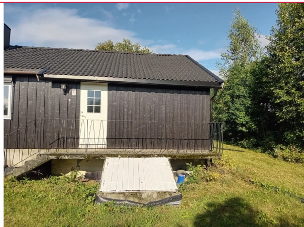
Inngangsparti med lem ned til kjelleren.
