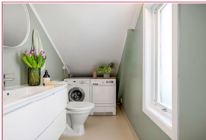
Gulvvarme og opplegg for vaskemaskin
