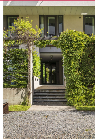
Inngang fra baksiden av bygget
