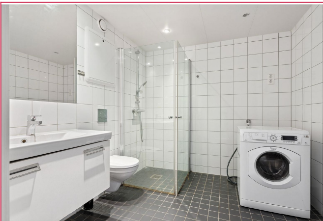
Flislagt bad med varmekabler av god størrelse.
