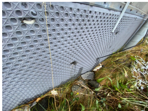
Bildet viser deler av grunnmursplast.
