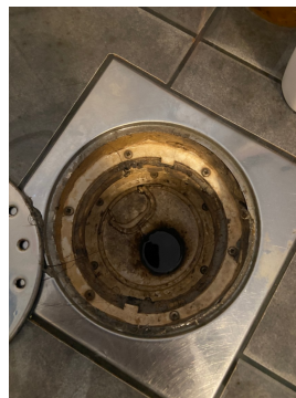
Bildet viser sluker på bad/vaskerom.
