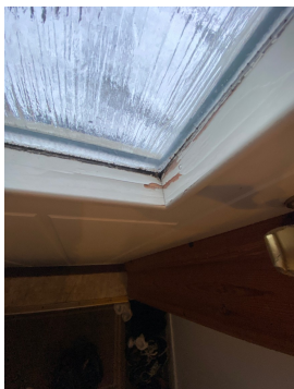
Bildet viser flakkende maling på glasslist.
