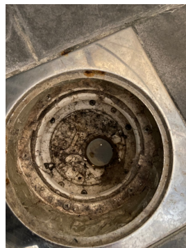
Bildet viser sluker på bad/vaskerom.
