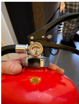
Bildet viser pulverapparat, utgått på dato.
