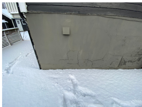
Bildet viser utvendig mur.
