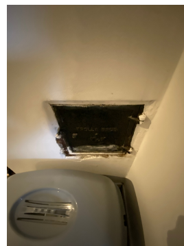
Bildet viser feieluke etablert i gangen.
