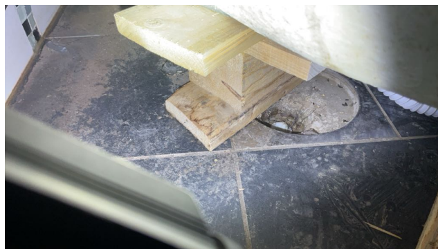
Ikke godkjent sluk eller egnet membran overgang
