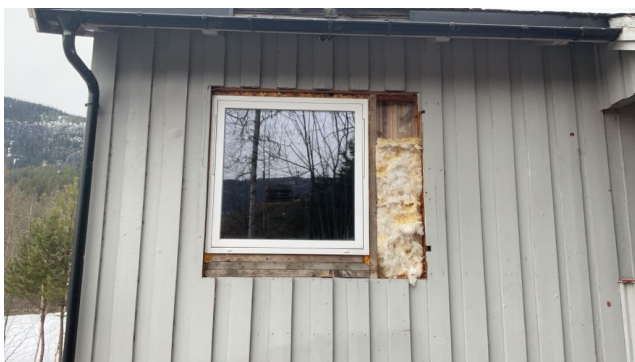
Åpninger i vegg
