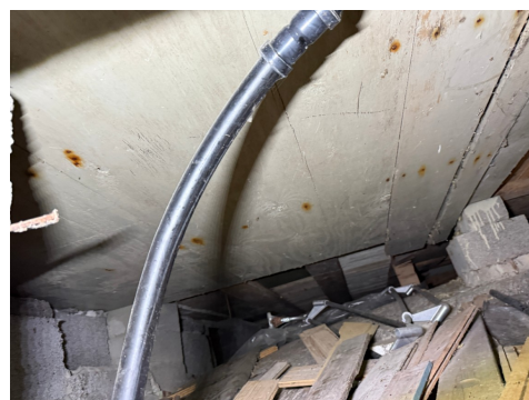
Avløpsrør til kjøkken fra etasjeskiller
