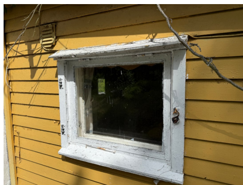
Eldre slitte vinduer
