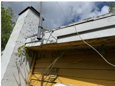
Riss og løsnet puss på pipestamme
