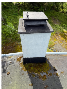
Riss og løsnet puss på pipestamme
