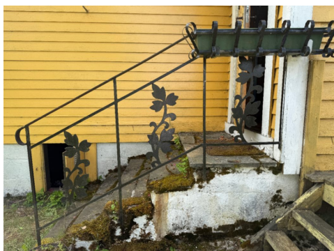
Mosegrodd og slitt oppmurt trapp med skifertrinn.
