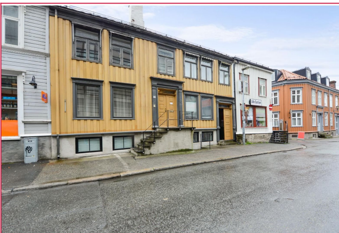
Fasade. Leiligheten ligger i høy 1.etg på venstre side.
