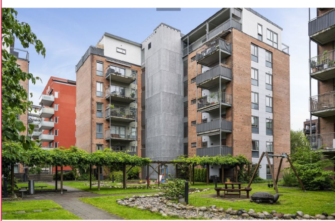
Fasade - sett fra bakgården.
