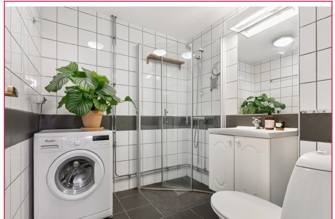
Flislagt baderom med varmekabler i gulv.
