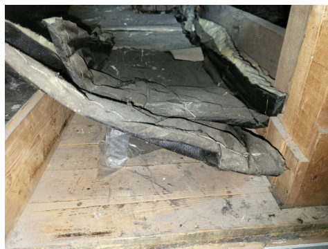
Isolering av sydde matter.
