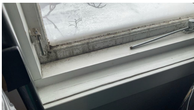
Råteskade i karm og punktert rute.
