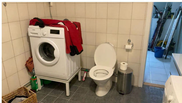
Vaskemaskin og gulvtoalett.
