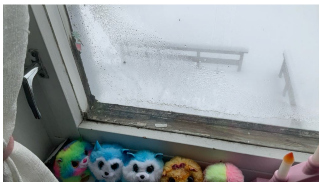
Råteskade i karm og punktert rute.
