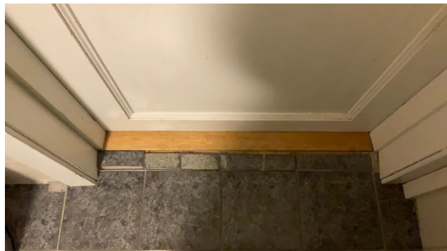
Ingen tilluft under dørblad.
