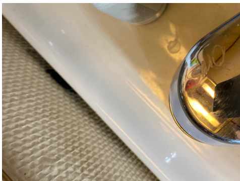
Manglende fuging mellom servant og vegg
