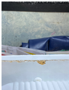
Skrog og bunnplater er fuktskadet/itsvelt
