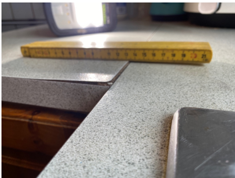
Utsvelt og fuktskadet benkeplate.
