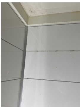
Det er påvist tegn til fuktskader i overflater.
