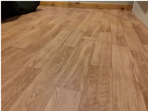
Gulvbelegg er ikke limt til underlaget
