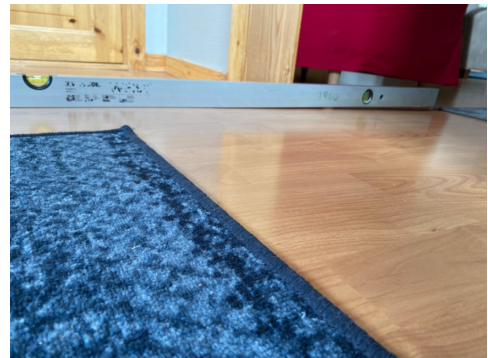
Skjevheter i gulv mellom kjøkken og stue.
