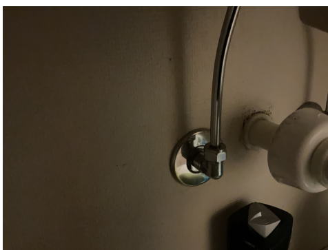
Utett rørgjennomføring
