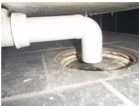
Utett rørgjennomføring
