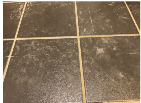
Sprekker i fliser
