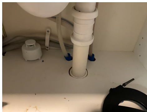
kontroll av røropplegget
