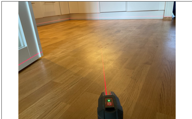
Nivellering kjøkken, ingen avvik registrert.
