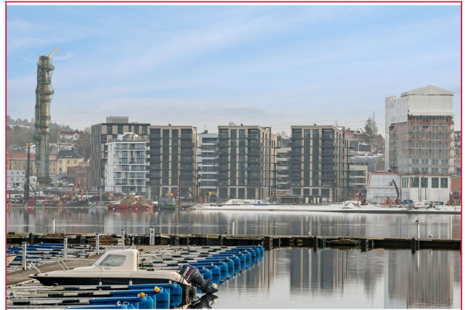
Frontleilighet i den nye bydelen på Verket
