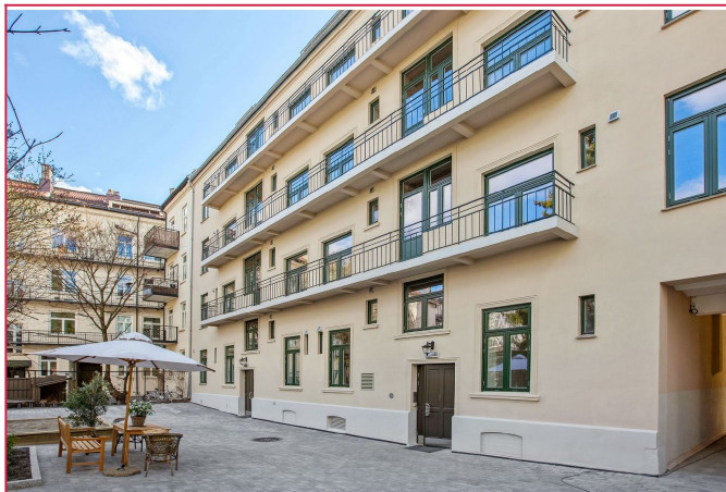
Bakgård med sittegruppe, sykkelparkering og felles brannbalkonger
