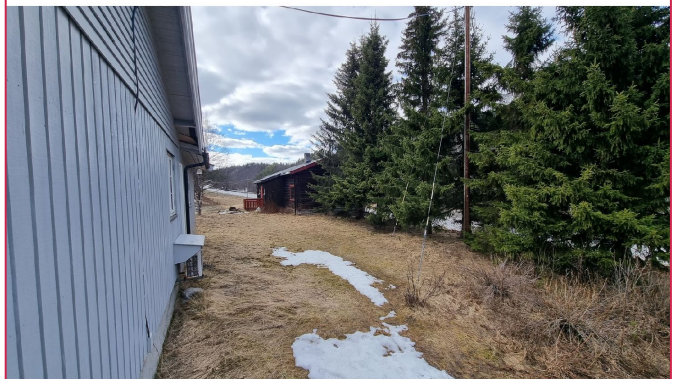
Hageflekk på kortsiden av huset.
