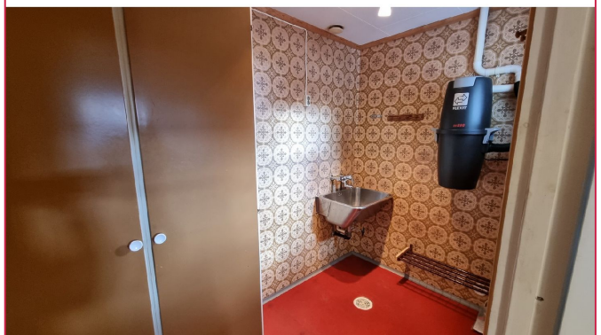
Vaskerom med sentralstøvsuger, opplegg til vaskemaskin og utslagsvask.
