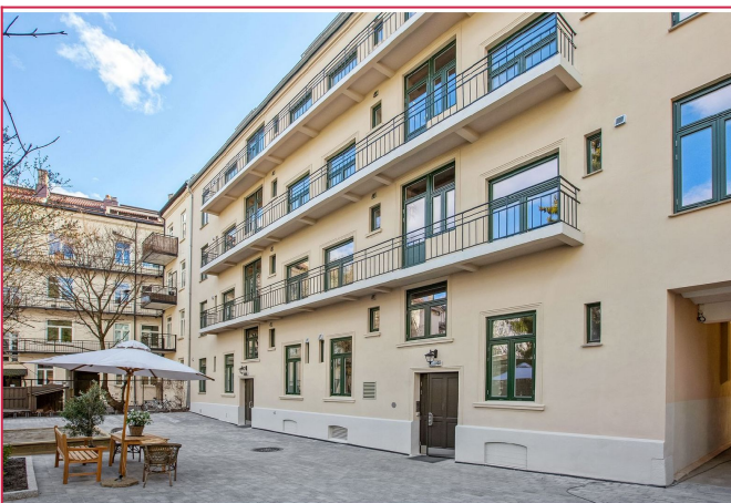
Brannbalkonger er felles og kan benyttes av hele sameiet
