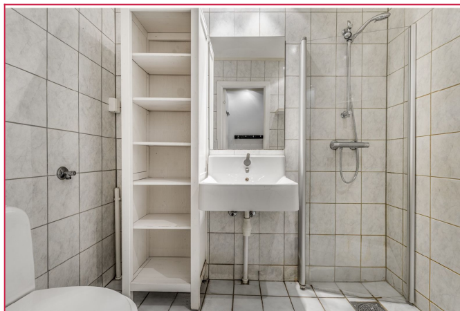
Flislagt bad med opplegg til vaskemaskin
