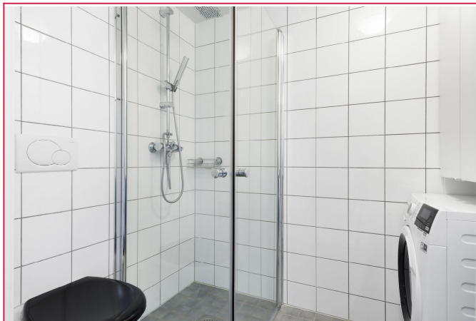
Flislagt bad med vaskemaskin
