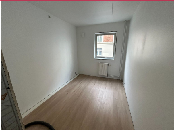
Soverom 2 - nymalt og nytt gulv. Rommet vil få nye lister.
