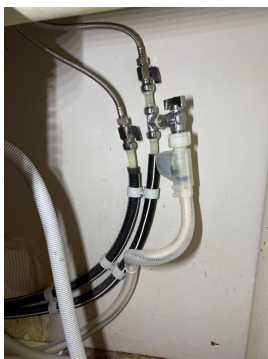
2 x stoppekraner i kjøkkenbenk.
