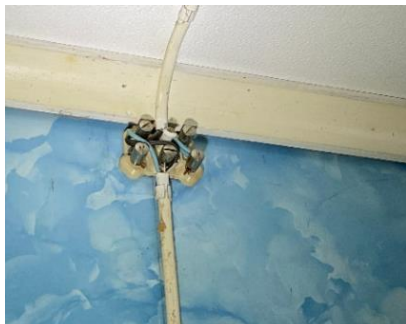
Mangler deksel på koblingsboks.
