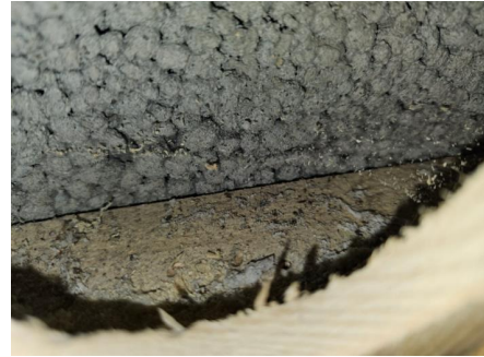
Ikke tegn til misfarging inne i konstruksjonen.
