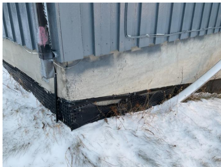
Taknedløp ført ned ved grunnmuren.
