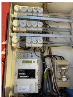
Mangler deksel på koblingsboks.
