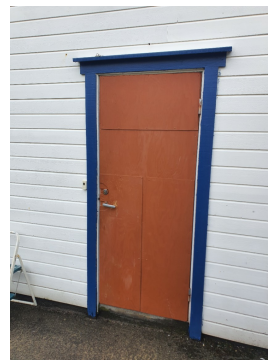
Dør med malt kryssfiner til loft
