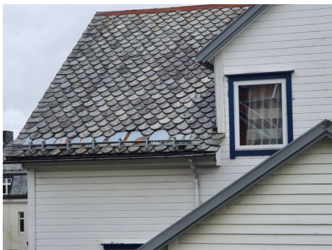
Mangler takstein og det er lappet inn med beslag.
