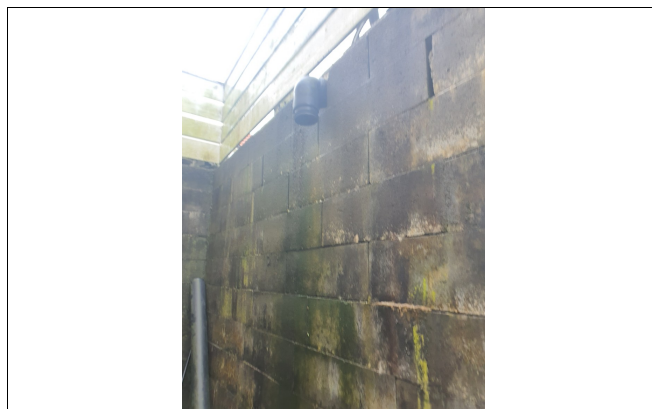
Avløp rett utfra mur mot øst
