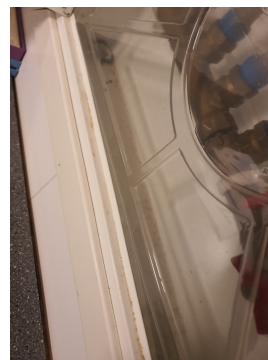
Ikke etablert avrenning og heller ikke stoppekran.
