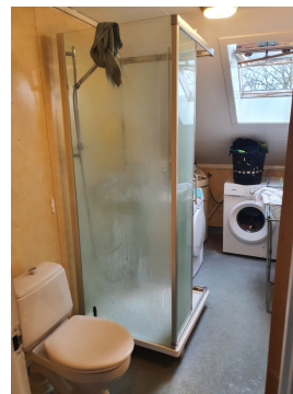
Dette er et bad/vaskerom for 6 personer!
