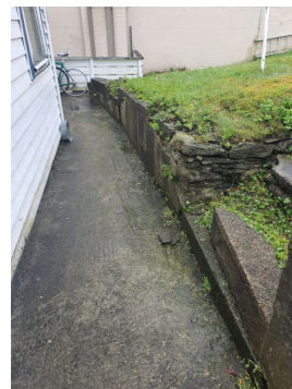
Fall fra terrenget mot boligen og eldre utett betongdekke.
