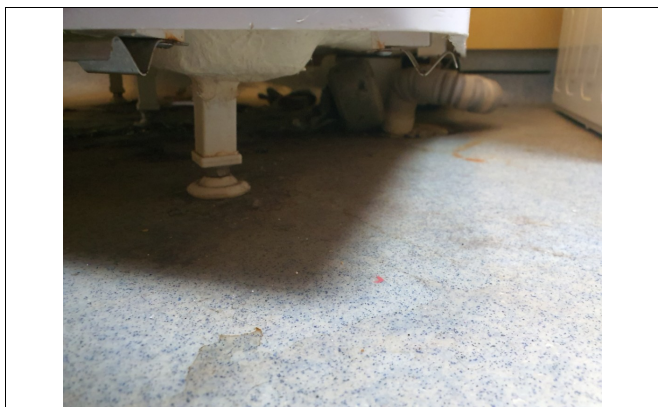
Avløp fra dusjkabinett til sluk.
