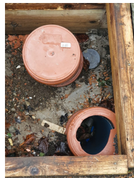
Dette er synlig på sørsiden på betongdekke.
