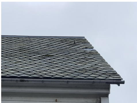
Mangler takstein og det er lappet inn med beslag.
