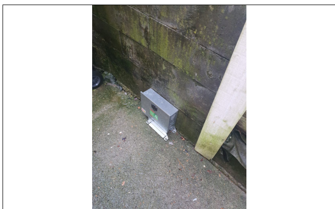
Det er tegn til at det er mus problem i boligen, da det er montert feller på utsiden.
