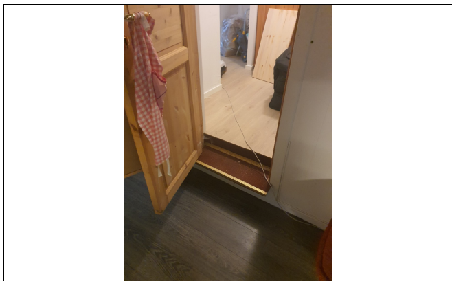
Oppbygging av gulv i bod i kjeller.
