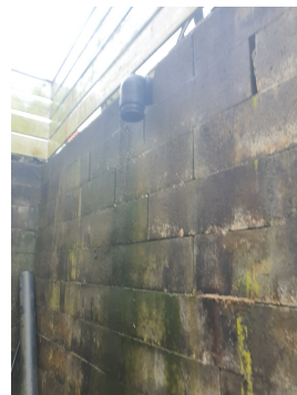
Bortledning av vann rett inn til nabo i øst.
