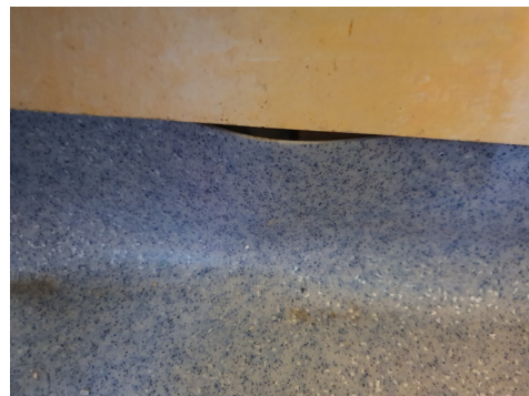
Gulvbelegg med åpning.
