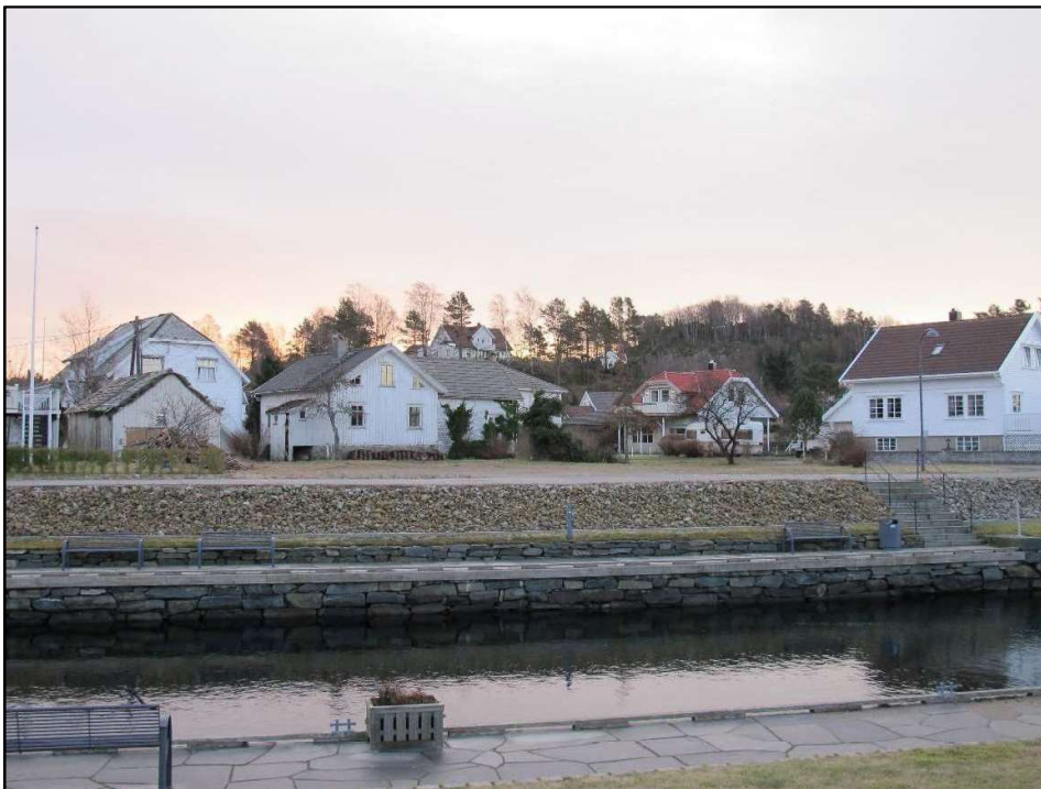
Figur 2. Planområdet sett fra motsatt side av kanalen.
