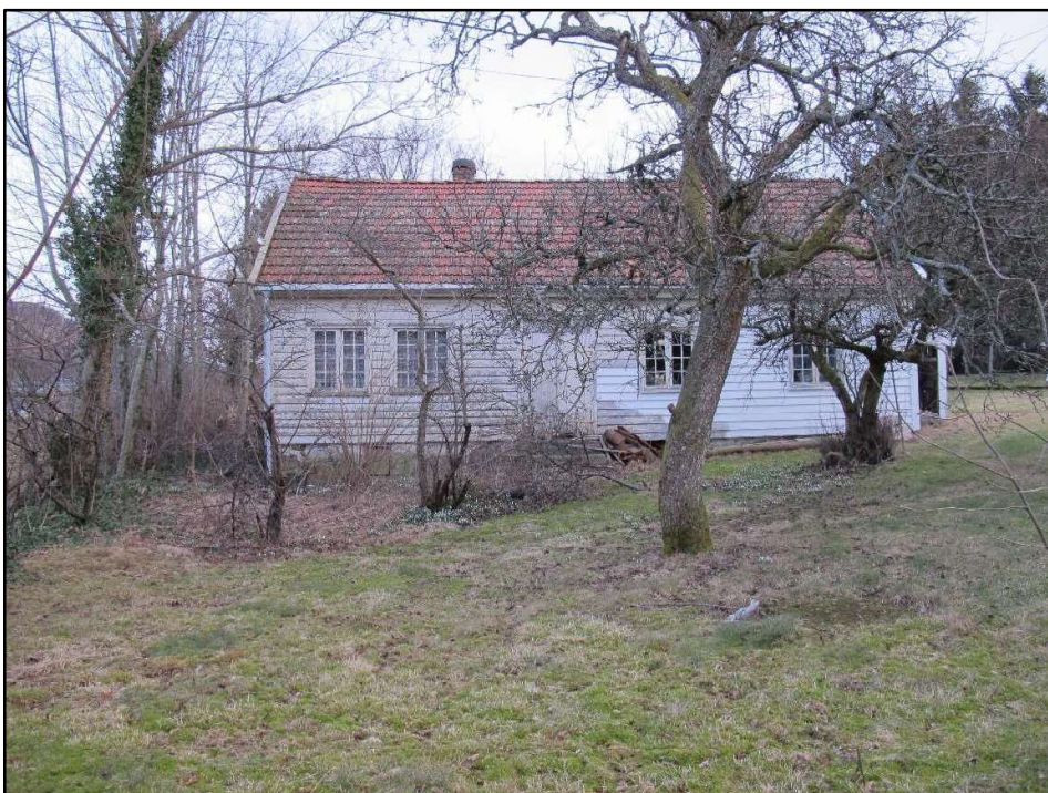
Figur 3. Et av de eldre husene i planområdet. Bygget er delvis restaurert med midler fra Fylkeskonservatoren, og planlegges bevart.
