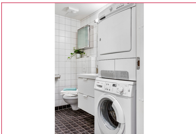
På badet er det opplegg for vaskemaskin og tørketrommel.
