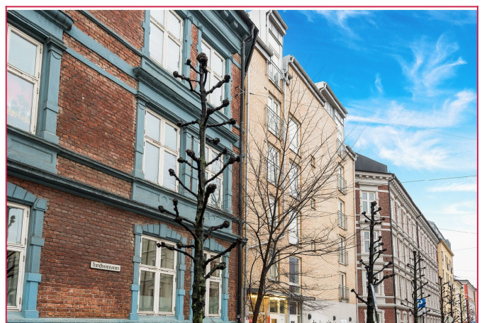
Fasade - Trondheimsveien 17 E.
