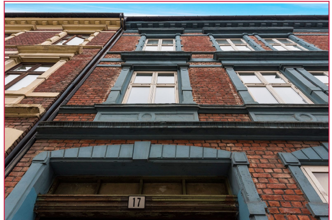
Fasade - Trondheimsveien 17 E.
