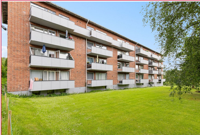
Fasade med store grønne fellesarealer. Leiligheten ligger i 2 etasje.
