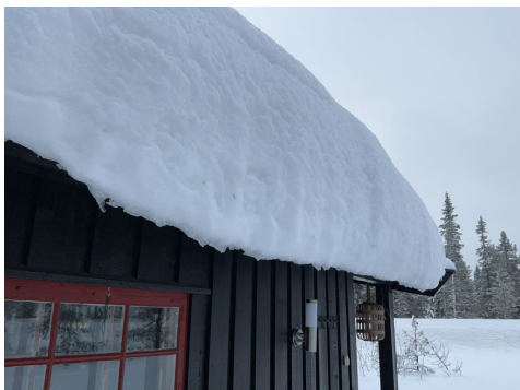
Begrenset inspeksjon pga snødekke
