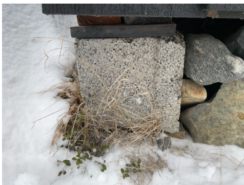
Enkel fundamentering på grunn
