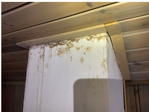
Brennbart materiale inntil pipestamme
