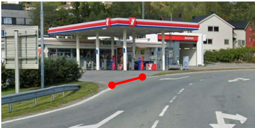
Figur 24. Stenging av eksisterende avkjørsel ved bensinstasjon
