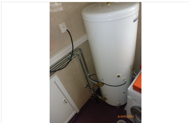
Bereder, stoppekran og sluk.
