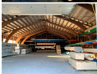
Oversikt innvendig bygning.
