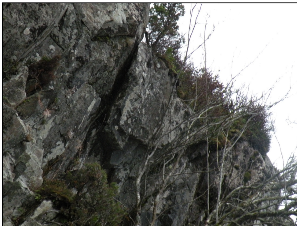
Figur 5: Sprekkeavgrenset blokk i skjæringen.
