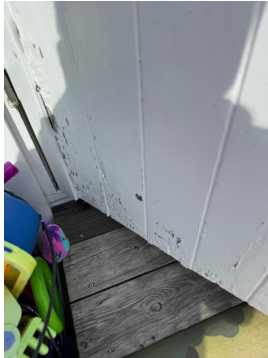
viser balkongdør med skadet finerplate
