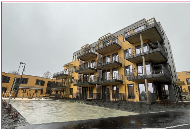
Leiligheten ligger flott til i byggets andre etasje, med balkong ut mot parkområde
