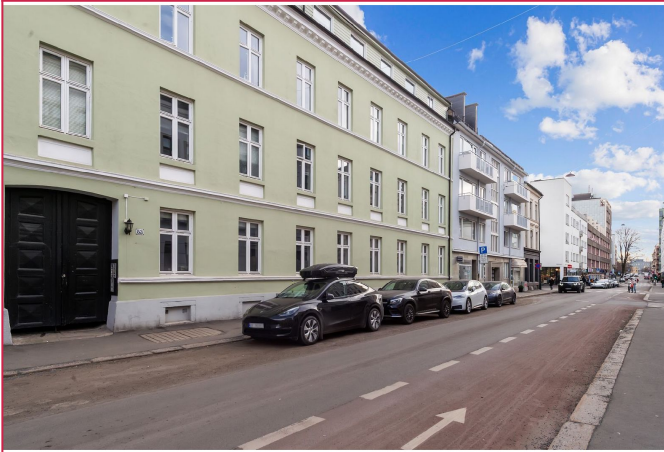
Fasade - leiligheten er ledig omgående
