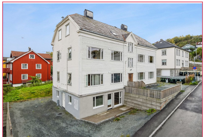
Fasaden. Leiligheten ligger i 2. etasje til høyre.
