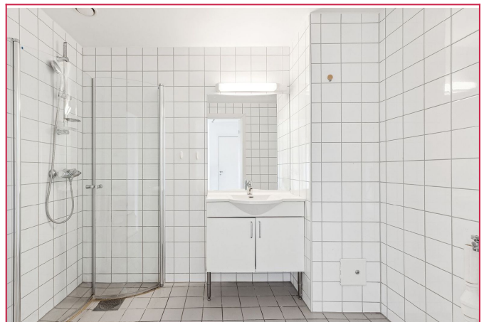
Flislagt bad. Opplegg for vaskemaskin.
